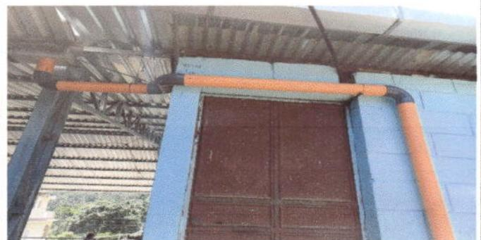
Foto 4: Suatitucion de bajada de Agua pluvial de metal por tubo PVC3"
